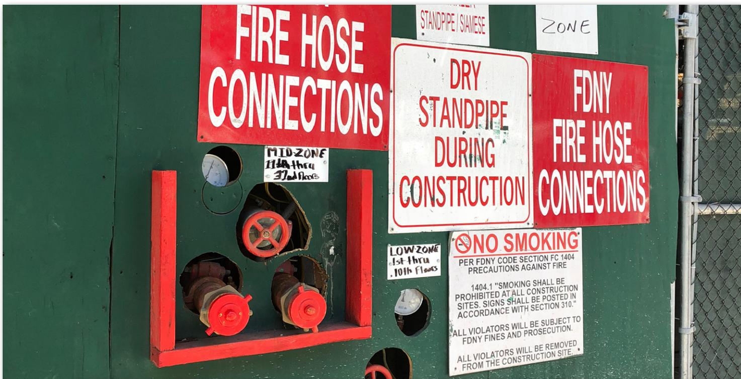
Figura 36. Las medidas temporales durante la restauración y la construcción deben estar claramente indicadas y ser fáciles de entender.
