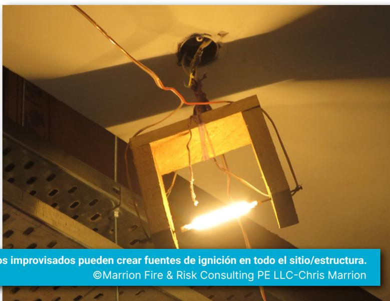
Figura 44. La iluminación, la calefacción y otros equipos improvisados pueden crear fuentes de ignición en todo el sitio/estructura.
