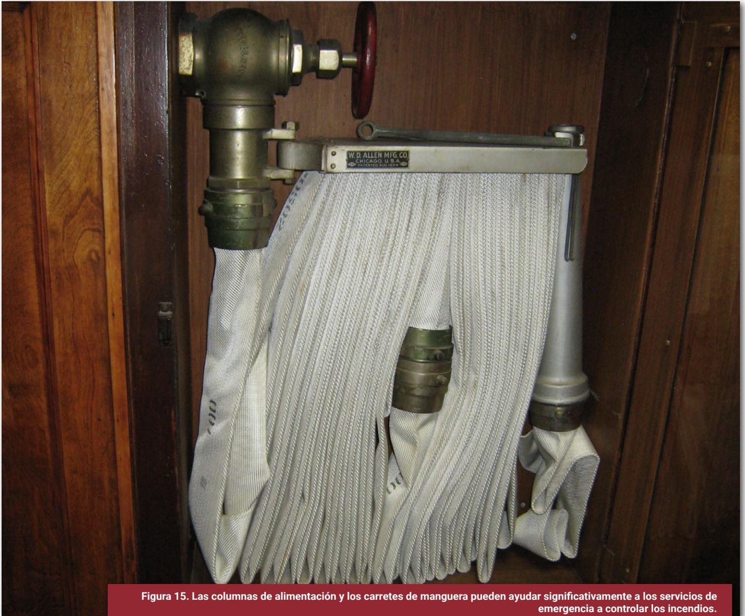
**Figura 15. Las columnas de alimentación y los carretes de manguera pueden ayudar significativamente a los servicios de emergencia a controlar los incendios.**
