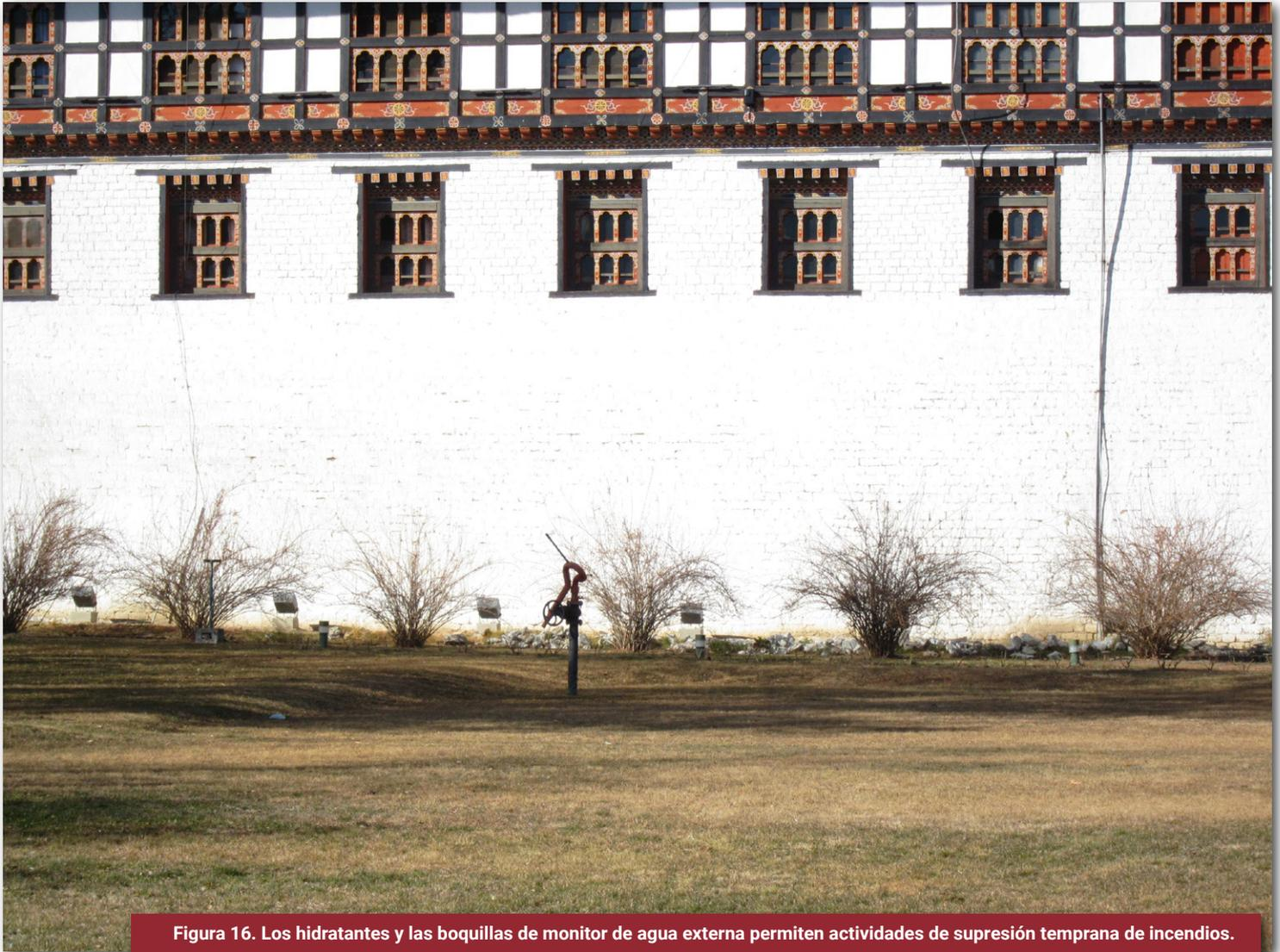
Figura 16. Los hidrantes y las boquillas de monitor de agua externa permiten actividades de supresión temprana de incendios.
