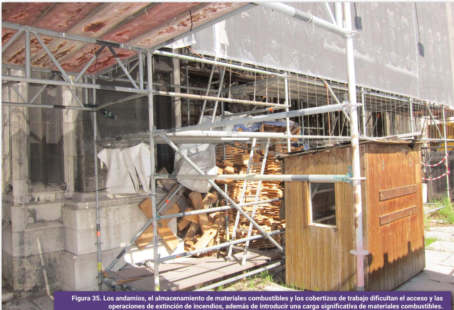
Figura 35. Los andamios, el almacenamiento de materiales combustibles y los cobertizos de trabajo dificultan el acceso y las operaciones de extinción de incendios, además de introducir una carga significativa de materiales combustibles.
