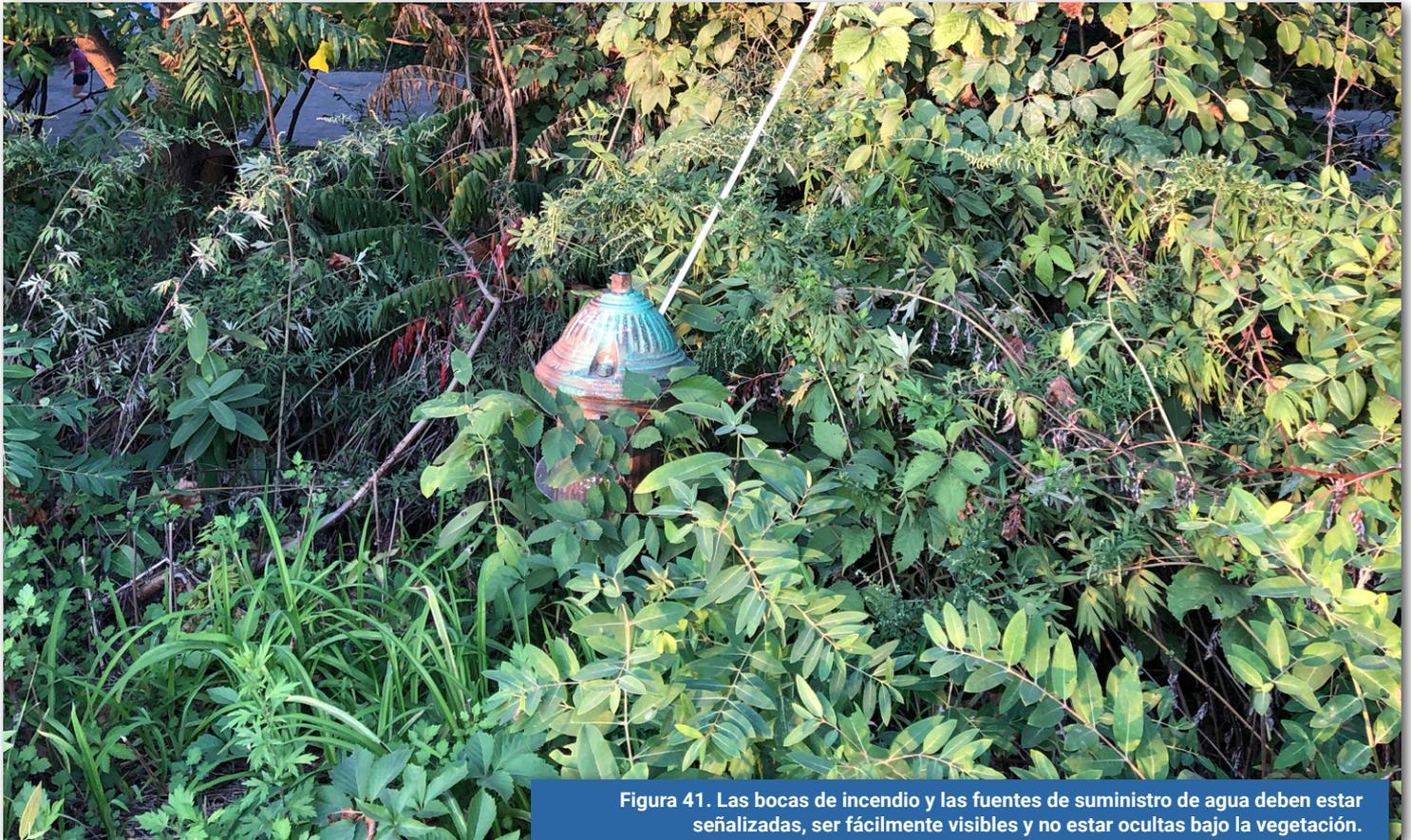
Figura 41. Las bocas de incendio y las fuentes de suministro de agua deben estar señalizadas, ser fácilmente visibles y no estar ocultas bajo la vegetación.
